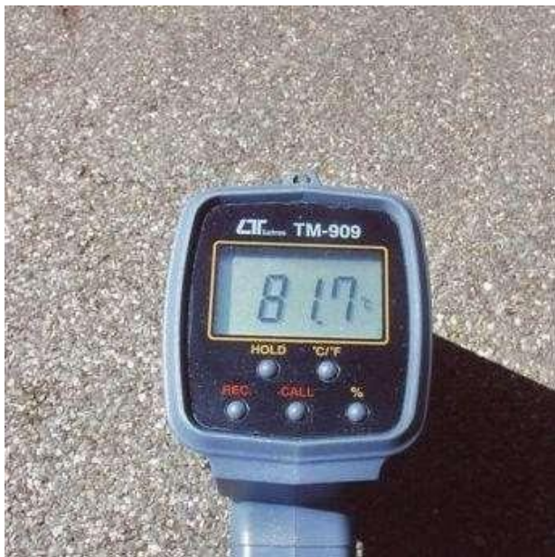
Rilevamento temperatura su copertura termoisolata con finitura ardesiata
