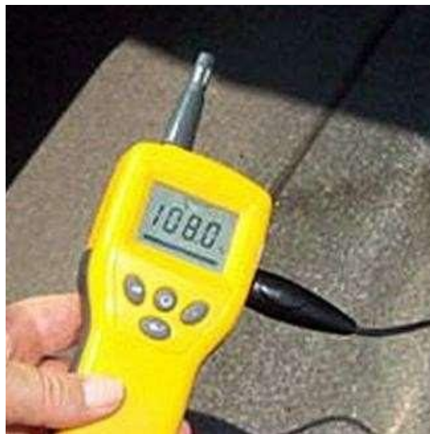
Rilevamento temperatura su copertura termoisolata con finitura ardesiata, ma adiacente ad superficie lucida riflettente
